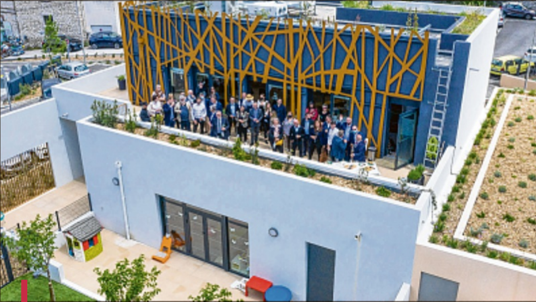
Avec sa fondation Capovert, le groupe immobilier a pensé un éco-quartier sur la commune de La Penne-sur-Huveaune. Un projet qu'il entend dupliquer à l'échelle nationale. /PHOTO DR
